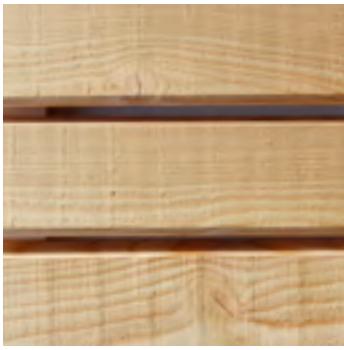
Feiner Bandsägenschnitt: Lärchenfassade in sägerauer Optik
